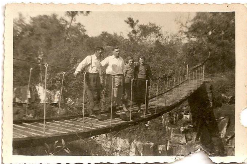
Foto 76 - Ponte pêncil em Guaíra
