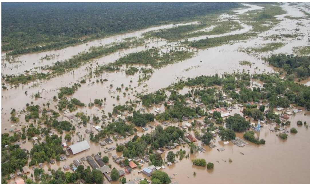
Fonte: Defesa Civil/2014. Vista área do distrito de São Carlos/RO.
