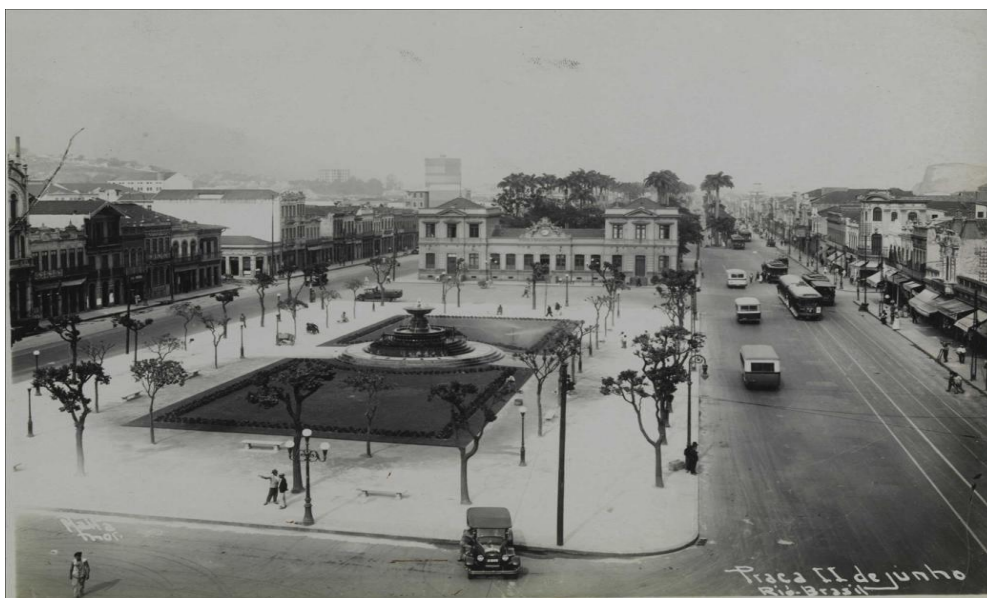
Figura 19. A Praça Onze, rodeada de cortiços. Seu nome oficial era Praça Onze de Junho, homenagem a data da Batalha do Riachuelo, 1865, durante a Guerra do Paraguai. A Praça Onze foi sendo reduzida desde os anos de 1930, e finalmente destruída, nos anos de 1940, para dar passagem à Avenida Presidente Vargas. Atualmente só resta um pequeno jardim, com o monumento em homenagem à Zumbi dos Palmares, próximo ao Sambódromo. Fonte: https://brasilianafotografica.bn.gov.br/?p=27390 . Acesso em: 31/10/2024.
