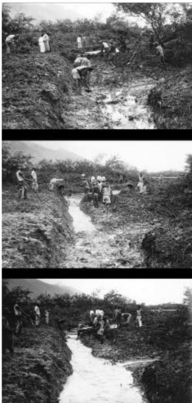
Imagem 7 - Obras de engenharia sanitária realizadas pelo Serviço de Profilaxia Rural em Campo Grande. Rio de Janeiro (RJ), entre 1918 e 1922. Arquivo Belisário Penna, Casa de Oswaldo Cruz/Fiocruz.
