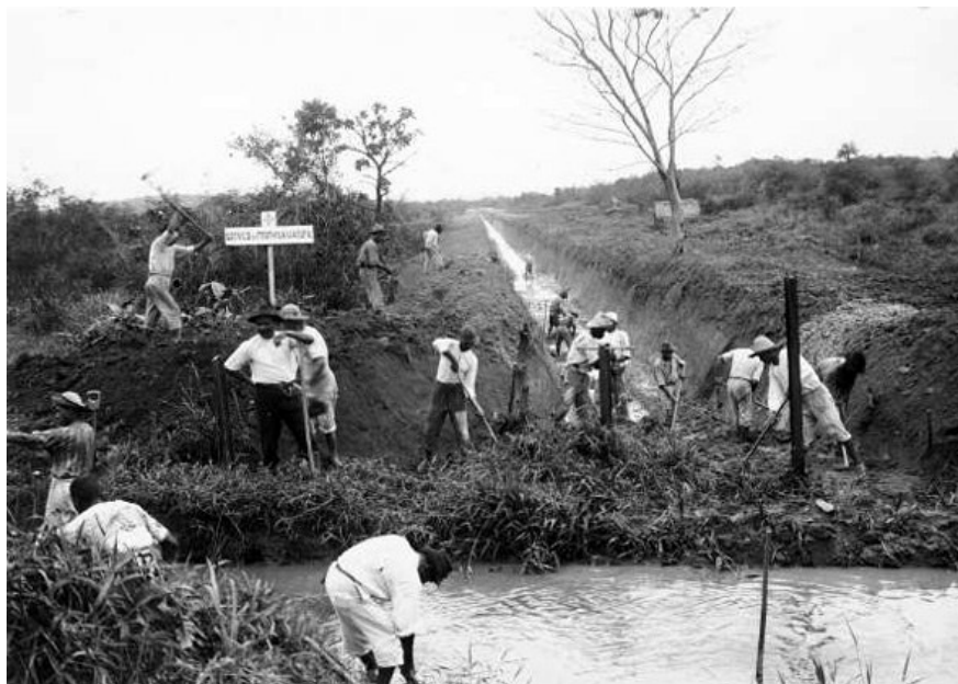
Imagem 5 - Obras de engenharia sanitária no bairro de Mesquita. Rio de Janeiro (RJ), 10 de novembro de 1922. Arquivo Belisário Penna, Casa de Oswaldo Cruz/Fiocruz.
