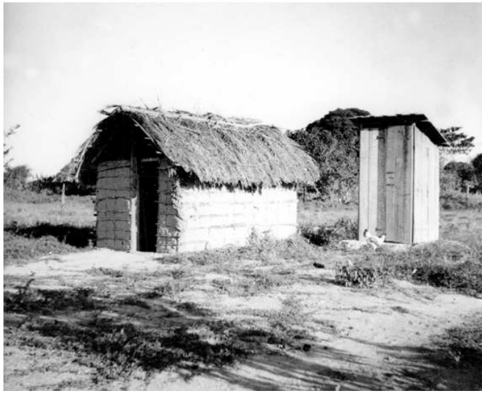
Imagem 30 - Construção de sentinas em Boa Vista. Território Federal do Rio Branco, entre 1945 e 1948. Arquivo Fundação Serviços de Saúde Pública, Casa de Oswaldo Cruz/Fiocruz.
