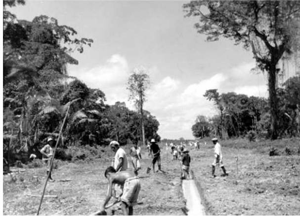
Imagem 27 - Obra de drenagem para controle de malária. Belém (PA), entre 1944 e 1946. Arquivo Fundação Serviços de Saúde Pública, Casa de Oswaldo Cruz/Fiocruz.
