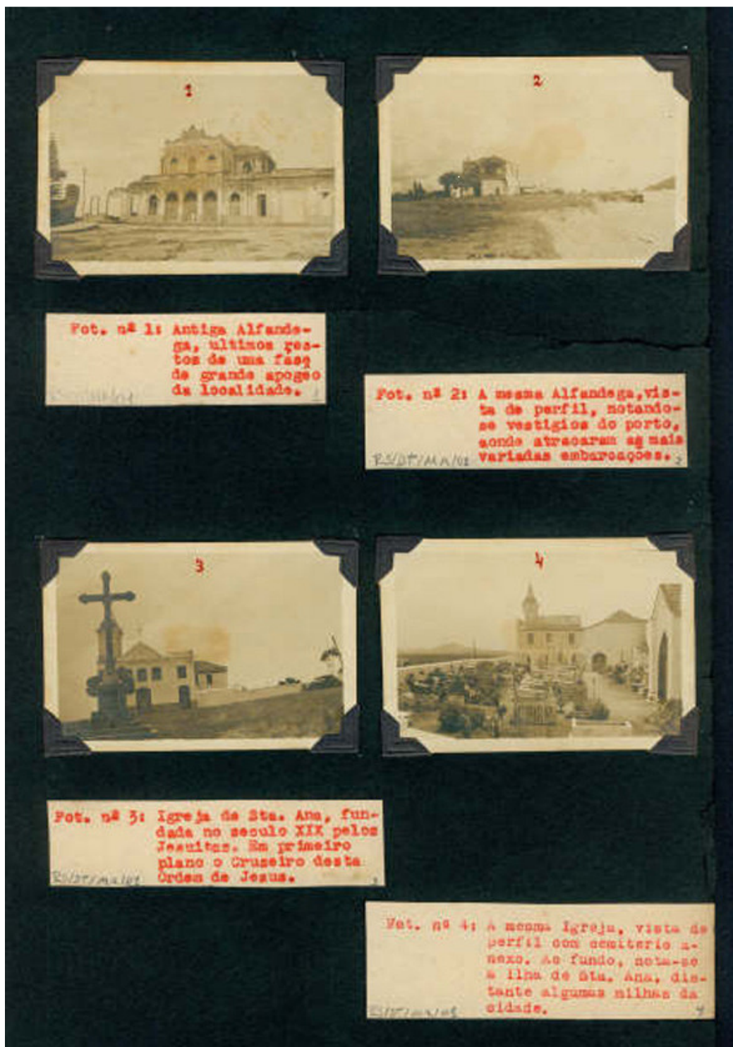
Imagem 49 - Foto 1: Antiga Alfândega, últimos restos de uma fase de grande apogeu da localidade. Foto 2: A mesma Alfândega, vista de perfil, notando-se vestígios do porto, aonde atracaram as mais variadas embarcações. Foto 3: Igreja de Sta. Ana, fundada no século XIX pelos jesuítas. Em primeiro plano, o Cruzeiro desta Ordem de Jesus. Foto 4: A mesma igreja, vista de perfil com cemitério anexo. Ao fundo, nota-se a ilha de Sta. Ana, distante algumas milhas da cidade. Arquivo Rostan Soares, Casa de Oswaldo Cruz/Fiocruz.
