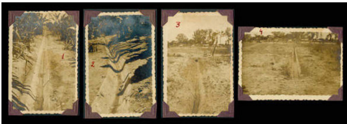
Imagem 53 - Drenagem do Morro de Sta. Ana. Foto 1: Uma das valas de contorno do Morro de Sta. Ana, drenando águas que formavam extenso brejo. Foto 2: A vala prossegue, fazendo pequena curva, necessária. Foto 3: Atravessando pequenos sítios, ganha o brejo, já semi-seco. Foto 4: Seqüência da mesma, vendo-se ao fundo pontilhão da “Vala dos Jesuítas” aonde ela desemboca. Arquivo Rostan Soares, Casa de Oswaldo Cruz/Fiocruz.
