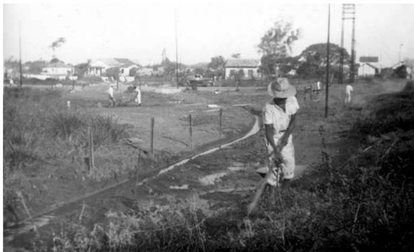
Imagem 48 - Aspecto das obras de engenharia sanitária desenvolvidas pelo Serviço Nacional de Malária. Macaé (RJ), 1943. Arquivo Rostan Soares, Casa de Oswaldo Cruz/Fiocruz.
