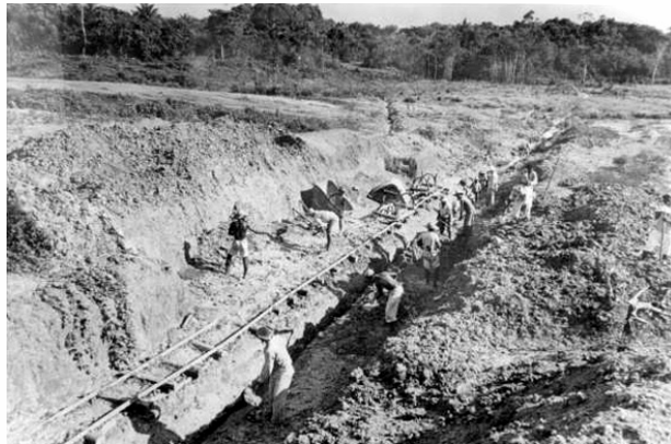
Imagem 28 - FISHER, Alan. Obra de drenagem e controle da malária. Porto Velho (RO), entre 1944 e 1946. Arquivo Fundação Serviços de Saúde Pública, Casa de Oswaldo Cruz/Fiocruz.
