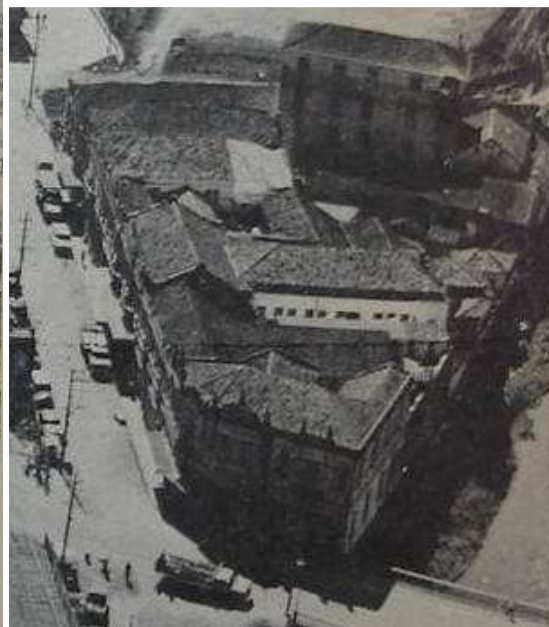
Detalhe dos “dormitórios”.
