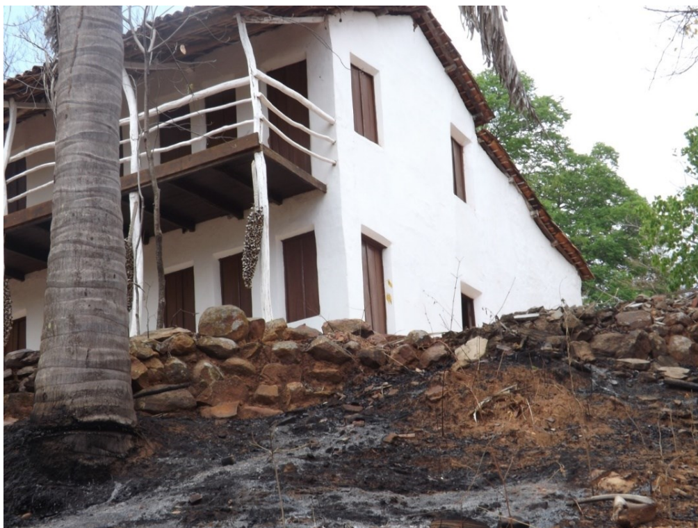
Figura 22 - Incêndio em Santuário Ecológico no Crato - CE
