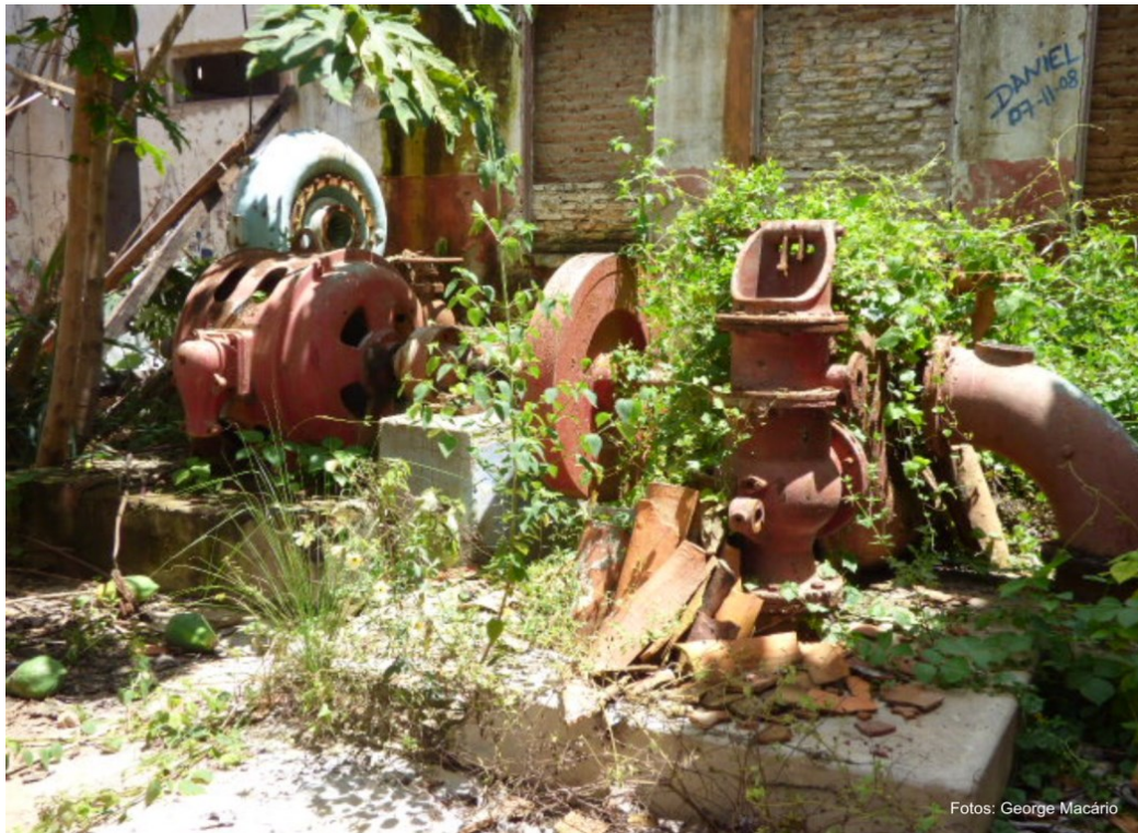
Figura 17 - Equipamentos das instalações da Antiga Usina hidroelétrica - Crato/CE
