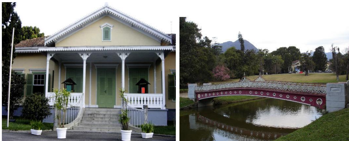
Chácara do Challet - Detalhe do Challet e das pontes de ferro. Fotos de Julho de 2008
