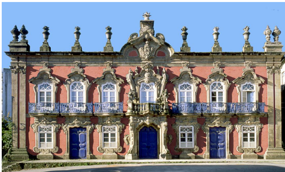
Figura 19 – Vista Frontal do Palácio do Raio
