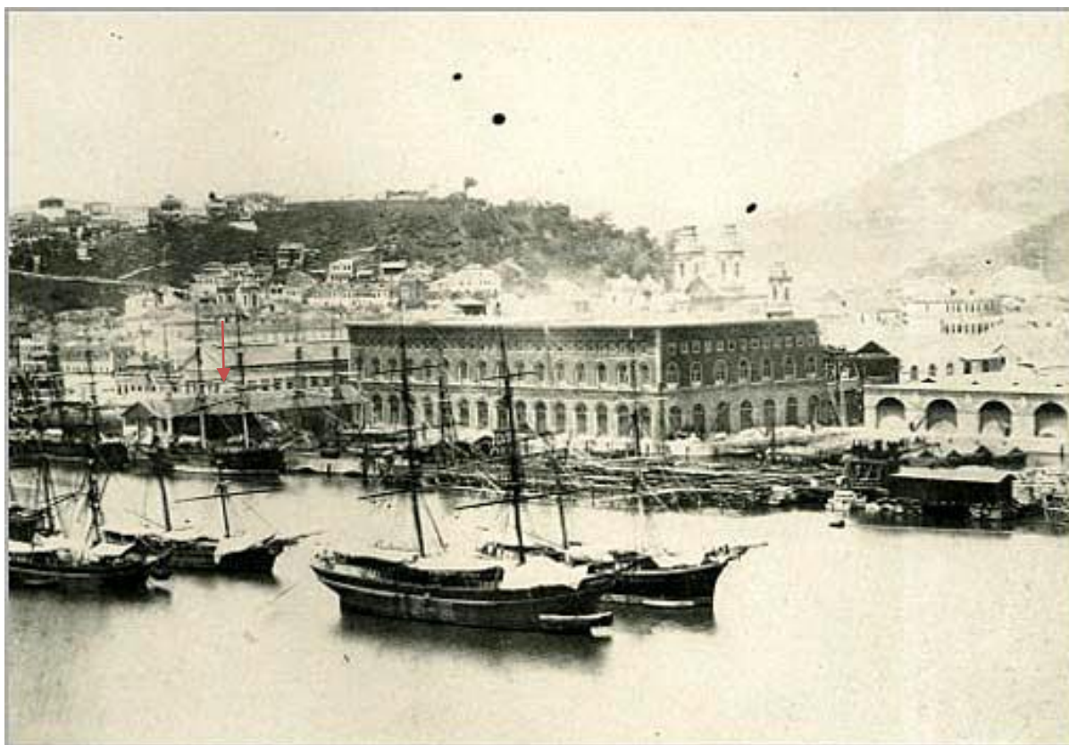
Figura 3.3: O Trapiche Maxwell (seta), o prédio do Lloyds e o novo cais em construção no RJ - 1865
