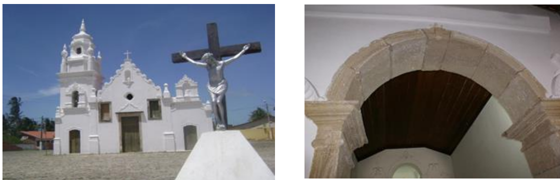
Figura 05. Imagens atuais da Igreja Nossa Senhora da Conceição, pertencente ao aldeamento de Almofala. À direita detalhe da abóboda de berço, e capitéis das colunas.
