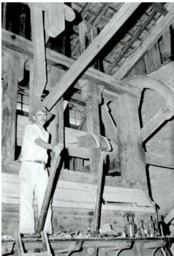
Figura 14. Engenho de pilões sendo acionado por um homem. Fazenda Cachoeira Grande, próximo de Engenheiro Nóbrega. Vassouras, RJ, set. 1948 - nov. 1949. (AEL, Coleção Stanley J. Stein, foto 186). Lino era responsável por uma dessas máquinas.
