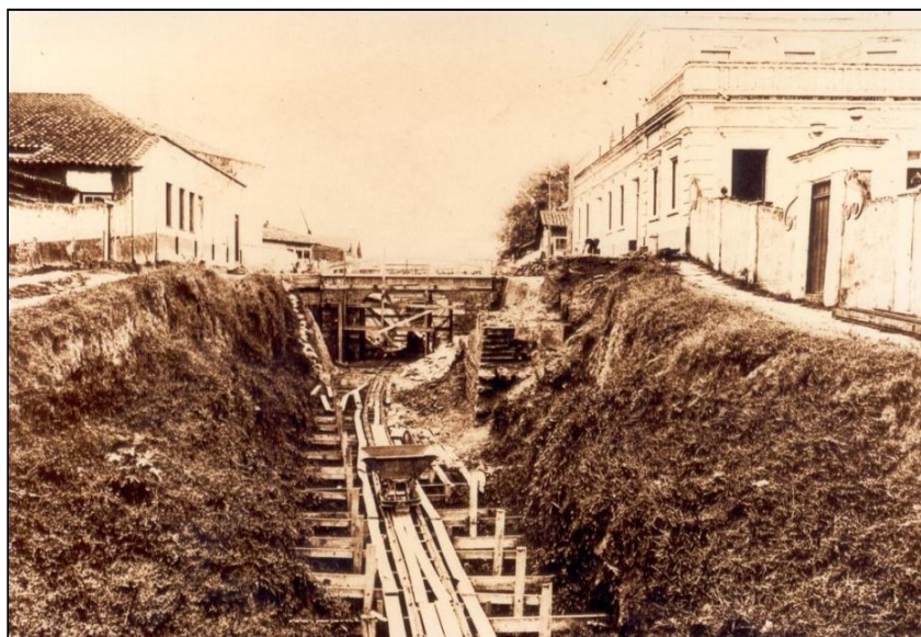
Figura 8 Trecho escavado do canal em Campos com uso de vagonetes
