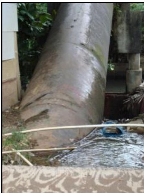
Ao lado: Foto 6: Vazamento na tubulação da Adutora. 2009.
