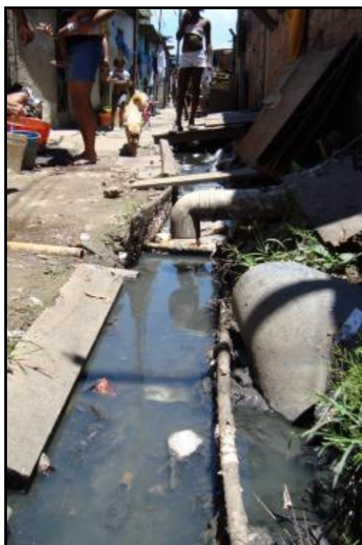
Foto 18: Esgotamento sanitário em vala aberta no Mandela de Pedra, 2009. Foto: Claudia Trindade. Acervo particular.
