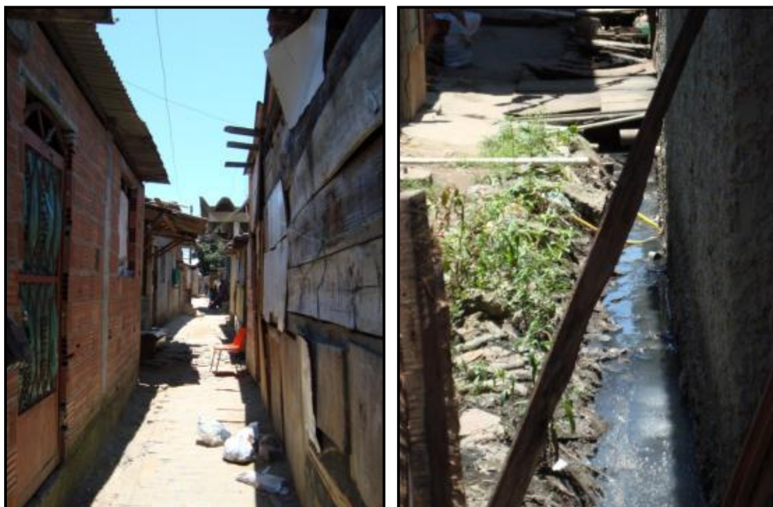
Fotos: 22 e 23: Becos da Embratel O primeiro com piso de paralelepípedo, o segundo de terra batida com vala a céu aberto – Novembro de 2008. Foto: Claudia Trindade. Acervo Casa de Oswaldo Cruz/Fiocruz.
