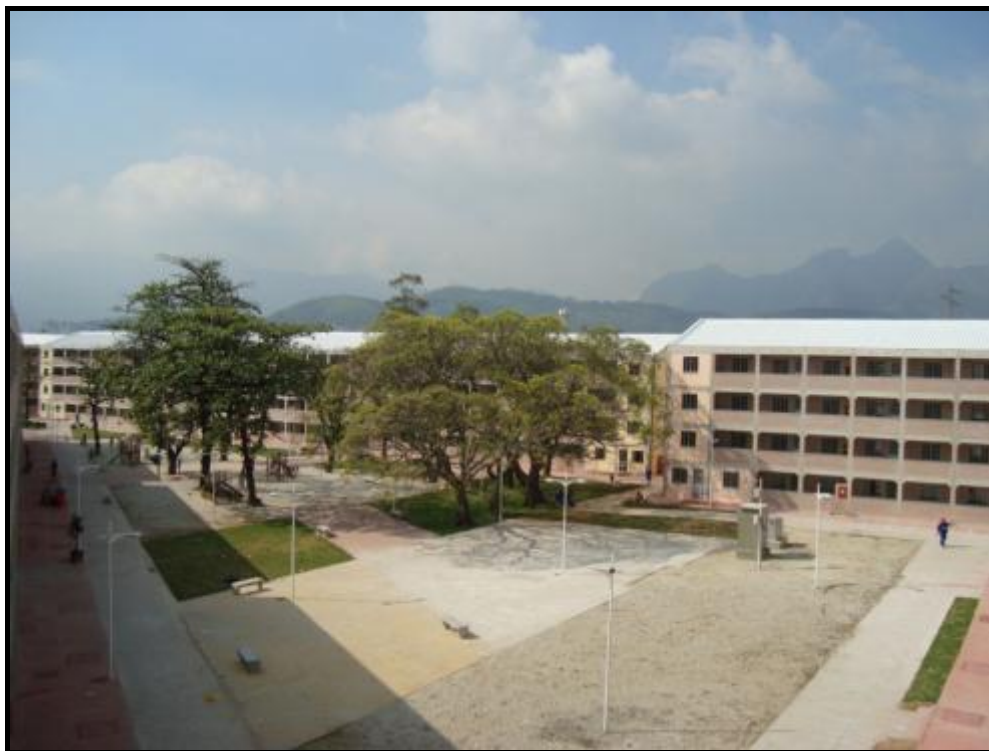
Foto 37: Imagem da área central do conjunto residencial erguido no terreno do DESUP. Janeiro de 2010. Foto: Claudia Trindade. Acervo Casa de Oswaldo Cruz/Fiocruz.
