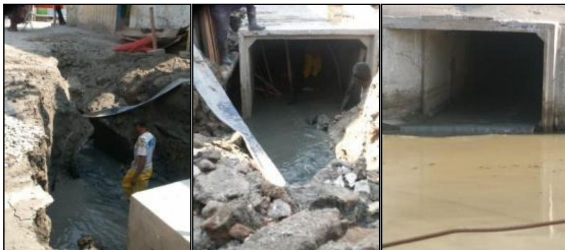
Fotos 47, 48 e 49: Substituição da tubulação de drenagem localizada na Estrada de Manguinhos desembocando no Rio Faria Timbó próximo à estação de trem. Setembro de 2009. Foto: Monica Dias.
