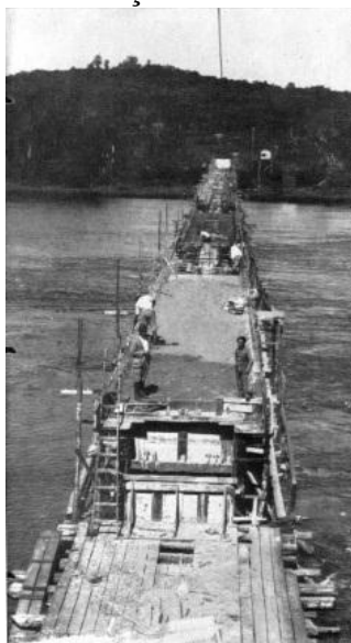
Figura 14:CONSTRUÇÃO DA PONTE DO RIO TIBAGI
