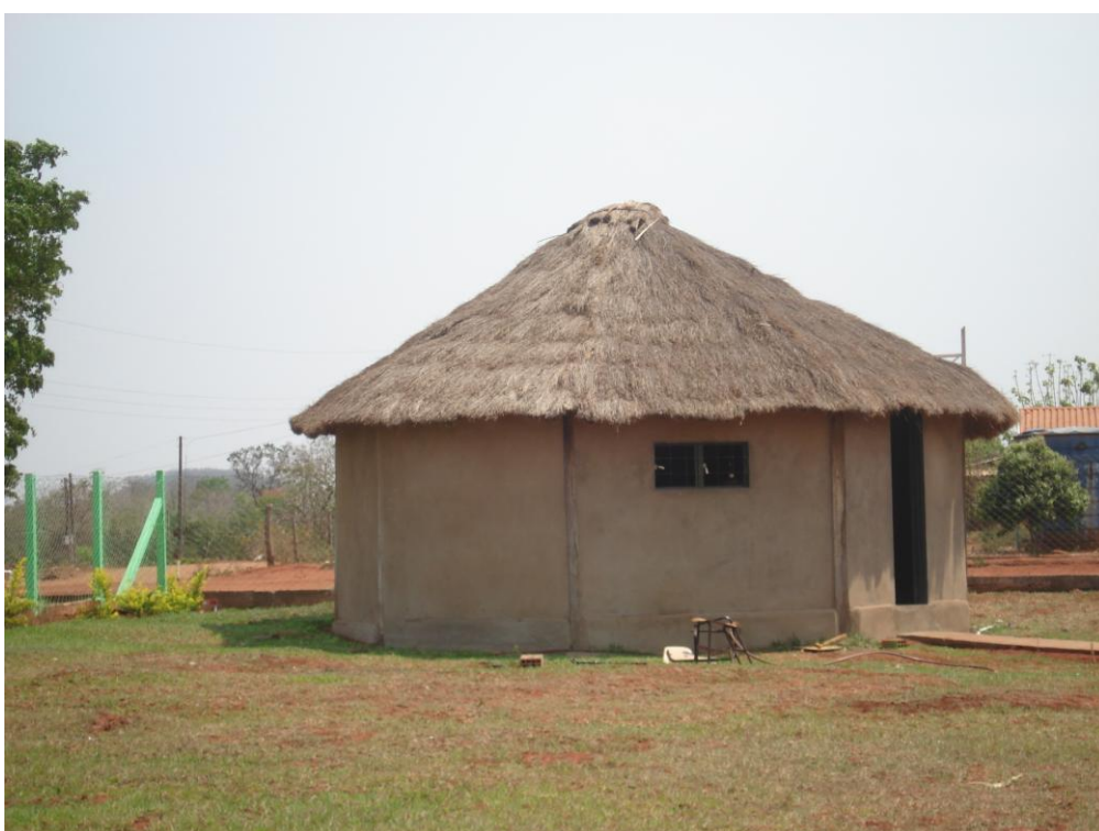
IMAGEM: 16 Construção prédio da biblioteca da Escola Alexina Rosa de Figueiredo Fonte: Vera Lúcia Ferreira Vargas LHIN/UFMS/CPAQ
