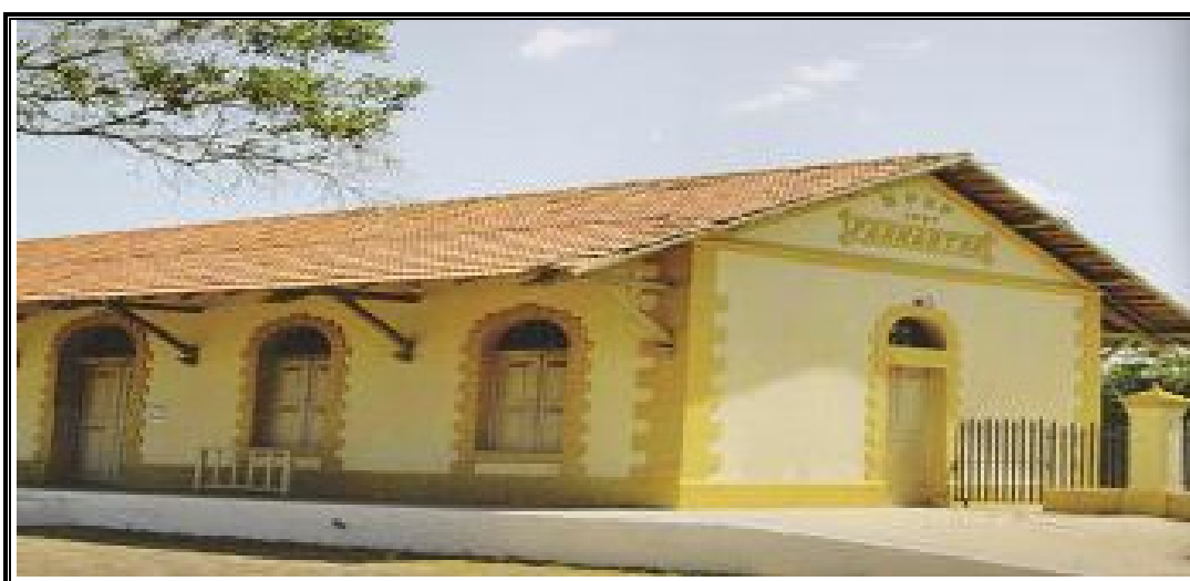
Figura 21 - Estação Ferroviária de Parnaíba.
