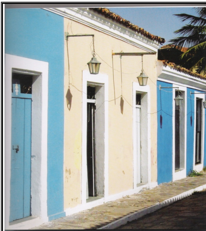
Figura 10 – Casario do Porto das Barcas.
