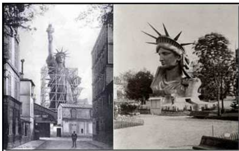
Construção da Estátua da Liberdade para a Exposição de Paris em 1878.
